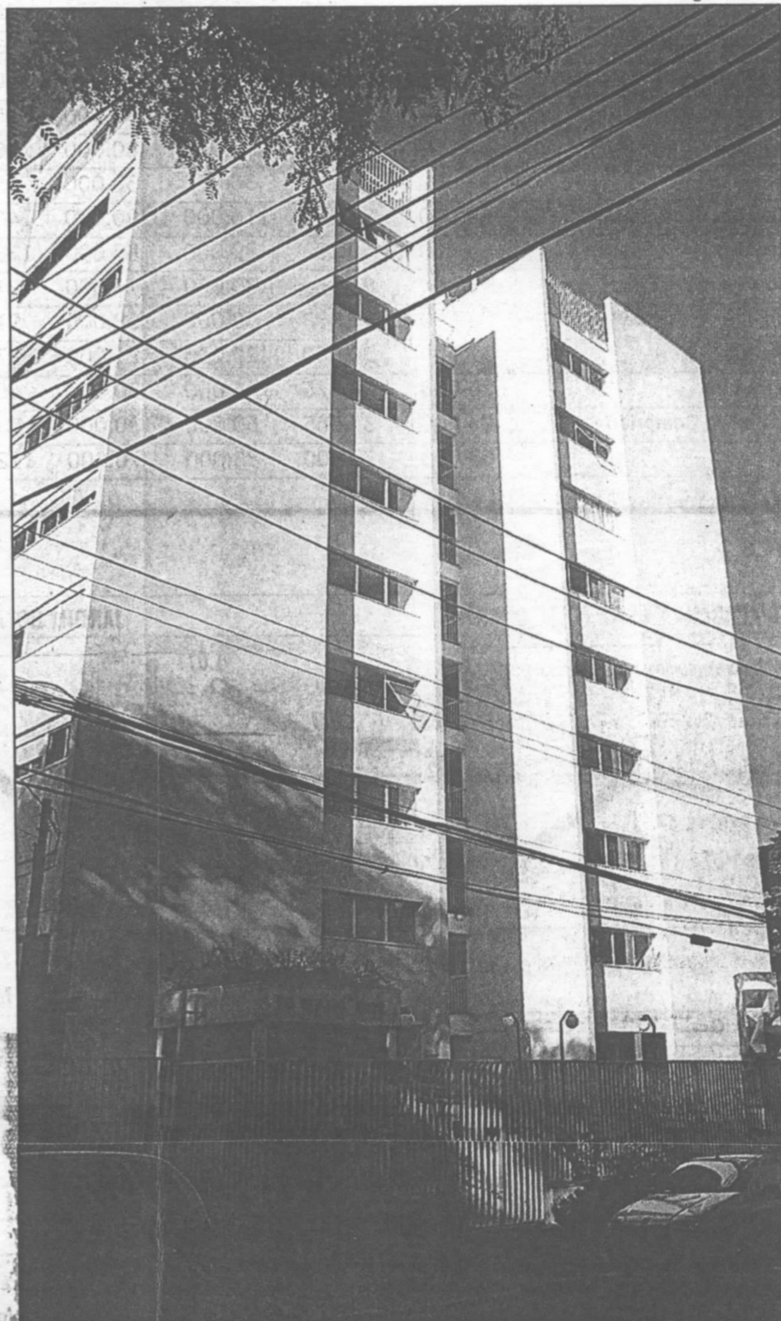
PRÉDIO EM São Paulo: janelas pequenas e acabamento em massa texturizada
